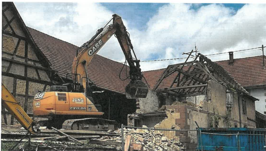
Démolisseur en action le 15 juillet 2024 - ©Association locale OZ'cour
