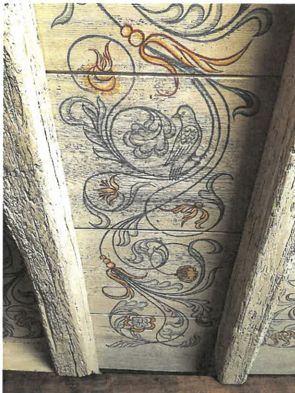
Ce plafond peint, dans l'entrée de la maison des Elbel, est inspiré du dessin d'époque retrouvé sur place.
